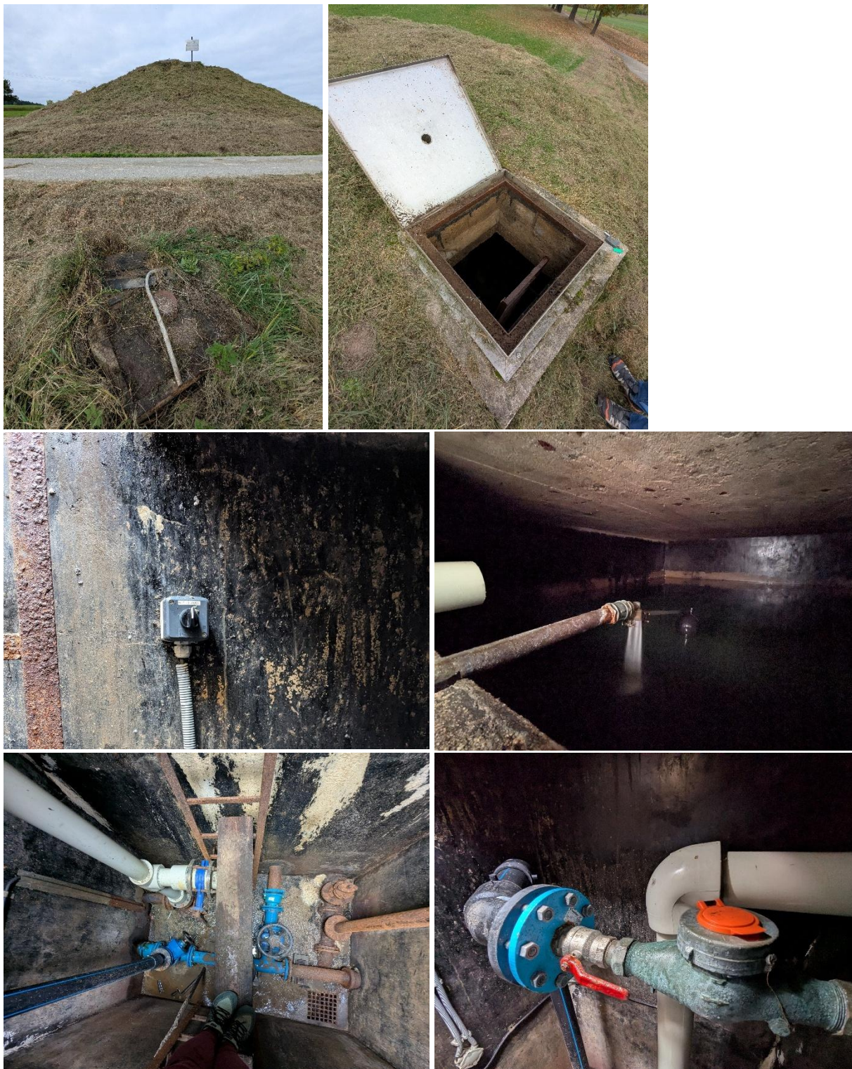
OBRÁZEK 3 – VODOJEM HABŘÍ. VLEVO NAHOŘE – CELKOVÝ POHLED, V POPŘEDÍ ODPADNÍ ŠACHTA. VPRAVO NAHOŘE – VSTUP DO VODOJEMU. VLEVO UPROSTŘED – SPÍNÁNÍ ČERPÁNÍ Z VODOJEMU LÍPÍ. UPROSTŘED VPRAVO – POHLED DO AKUMULAČNÍ KOMORY. VLEVO DOLE – ARMATURNÍ ŠACHTA SPODNÍ ČÁST. VPRAVO DOLE – MĚŘENÍ MNOŽSTVÍ SUROVÉ VODY V ARMATURNÍ KOMOŘE.
